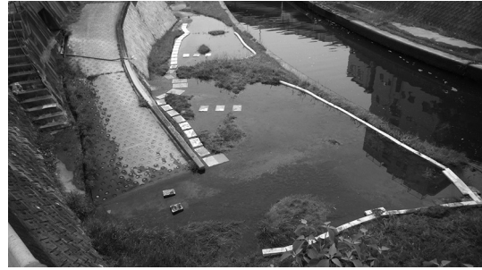
図4：高水敷のビオトープ
